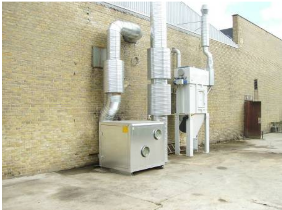
26 Procesudsug fra maskinværksted via ol
