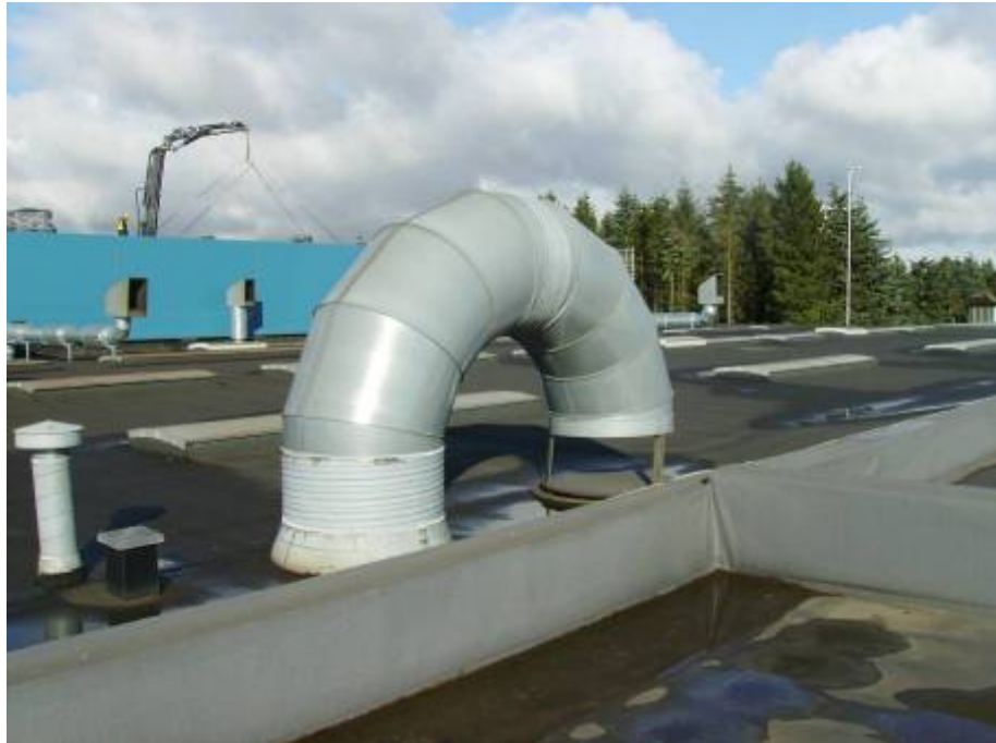
10 Indsugning til Dantherm varmluf- tovn
