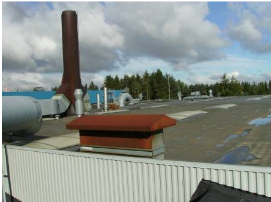
13 Indsugning til 3 malerkabiner
