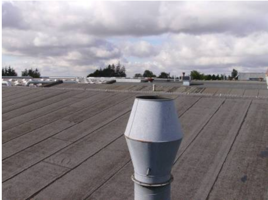
24 Afkast fra vaske- maskine i maskin- værks
