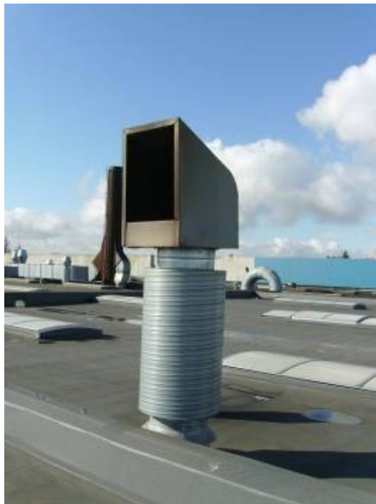
17 Afkaståbning fra udsugning småsvejs
