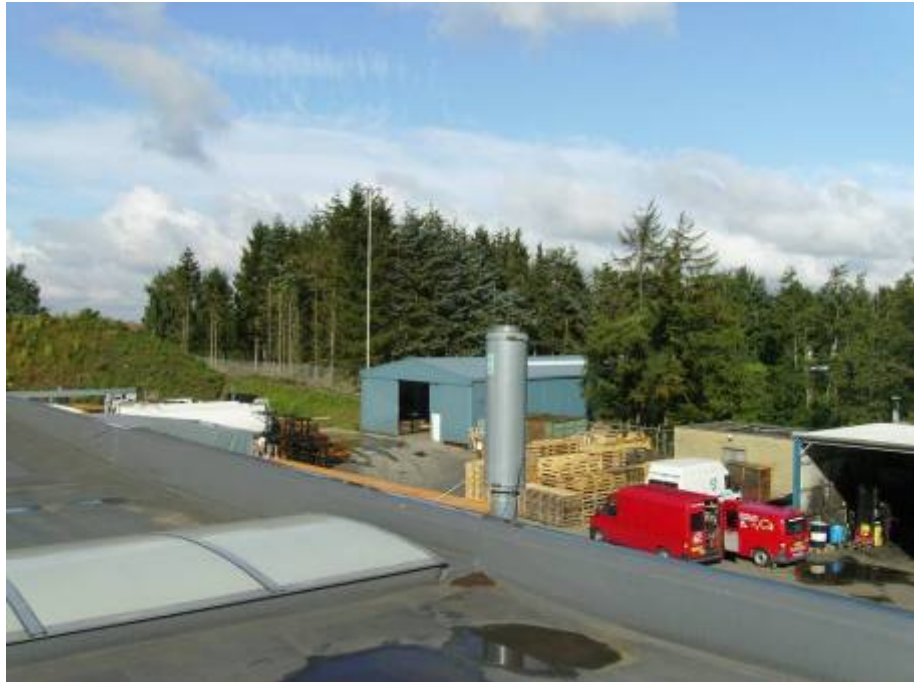
18 Afkast fra højtryksudsugning autogas
