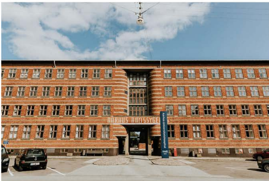
Omdannelse af Amtssygehuset. De oprindelige bygninger genanvendes til nye formål
