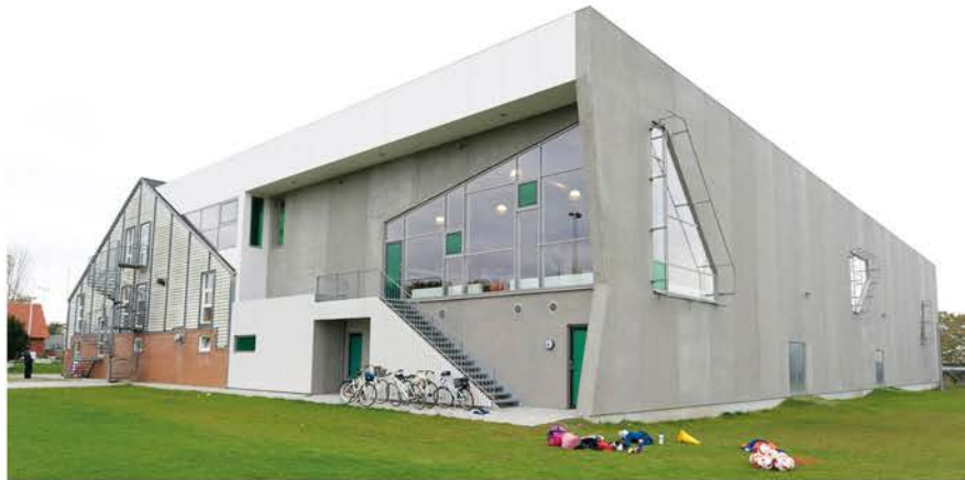
Springcenter Aarhus er en del af Vejlbj-Risskov Idrætscenter. Et centralt knudepunkt i lokalområdet, der tilbyder unikke ramme for bevægelse og foreningsaktiviteter
