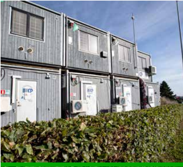
Byggepladsskure med luft til luftvarmepumper og energistyring.
